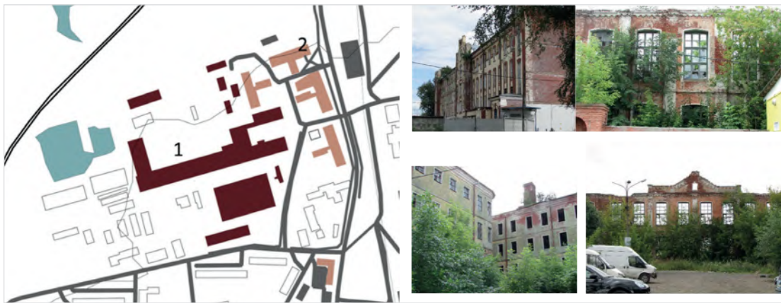
Рис. 3. Ликинская прядильно-ткацкая фабрика. Ликинская мануфактура А.В. Смирнова. ОКН РЗ. 1 — Здание Ликинской прядильно-ткацкой мануфактуры. Техническое состояние руинированное, планируется снос; 2 — Рабочие казармы
