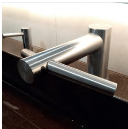
Рис. 1. Бесконтактный водоразборный прибор со встроенной сушилкой для рук (фото сделано и предоставлено доц., к. т. н. Орловым Е. В.)
