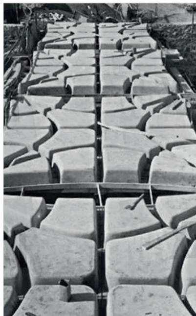
Рис. 3. Конструкция несъемной армоцементной опалубки шерстопрядильной фабрики Гатти в Риме (фото из интернет)
