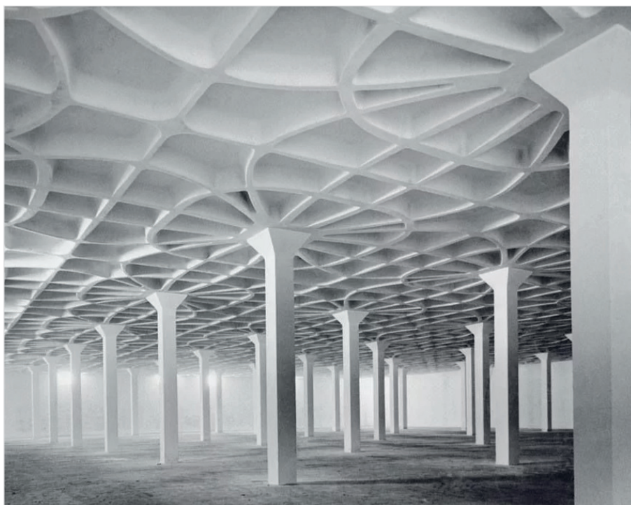
Рис. 1. Конструкция железобетонного покрытия шерстопрядильной фабрики Гатти в Риме инженера Пьера Луиджи Нерви (фото из интернет)
