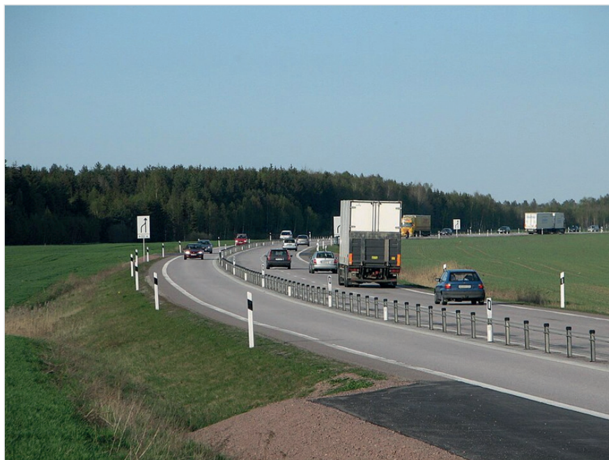
Рис. 5. Поперечный профиль шведской дороги «2+1» с тросовым осевым барьером (по материалам Trafikverket)
